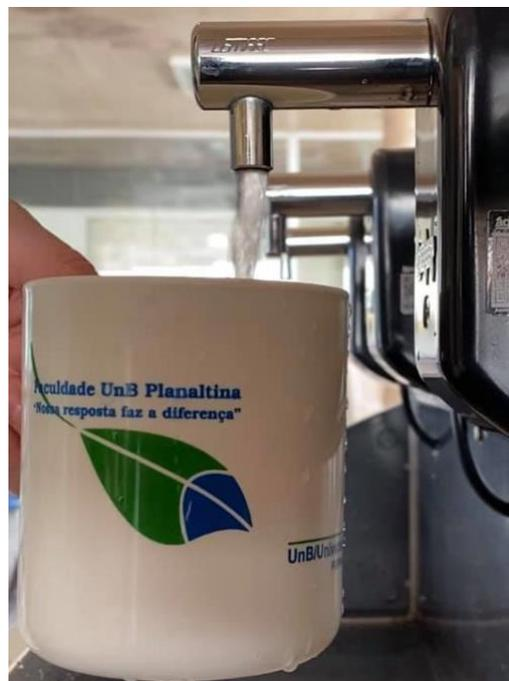
Figura 4 - Torneira com acionamento por sensor em bebedouro
