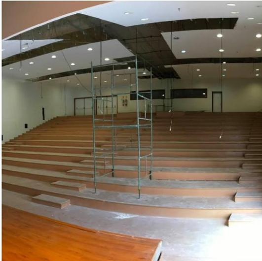
Figura 24. Início da remoção do forro.
