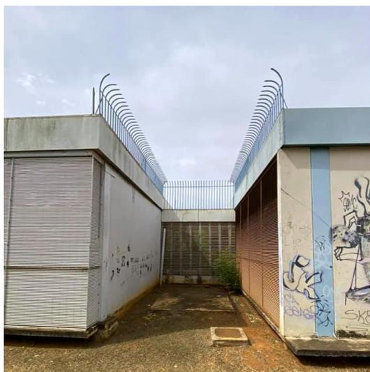
Figura 29. Exemplo de bloqueio ao acesso do telhado
